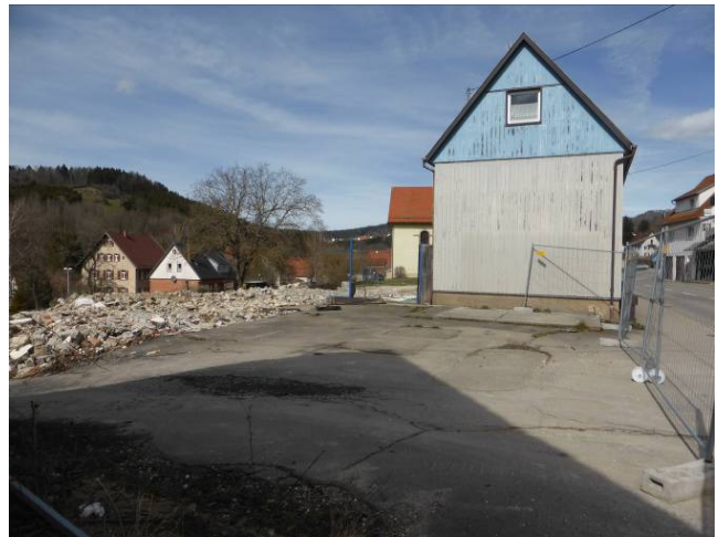
Foto 2: Rückgebaute Gebäude im Bereich der Hochholzstraße
