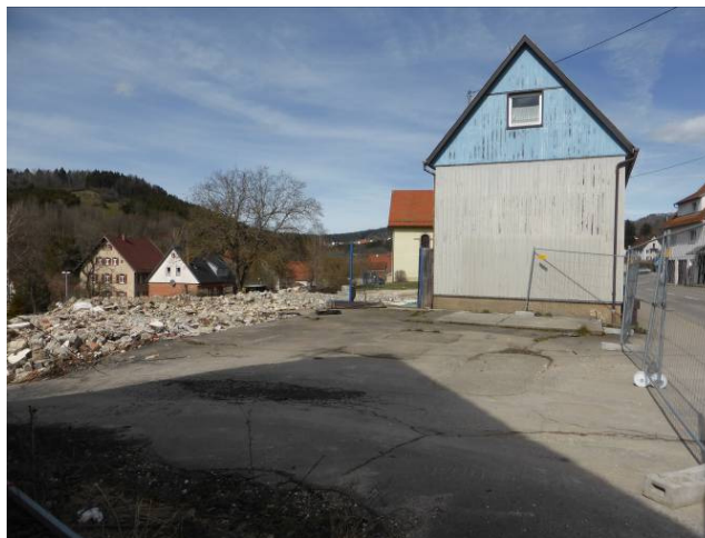
Foto 2: Rückgebaute Gebäude im Bereich der Hochholzstraße
