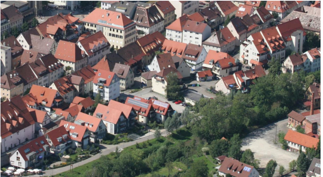
Klein Venedig nach der Sanierung
