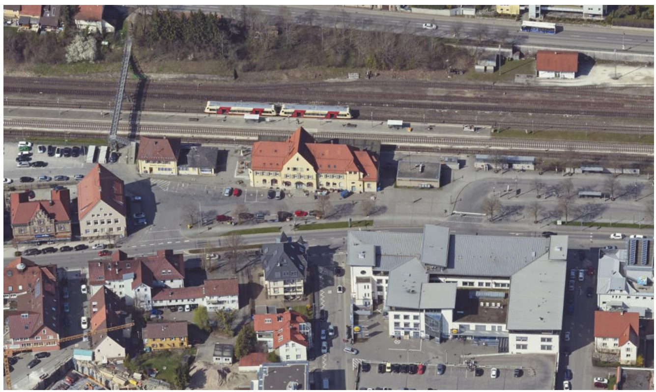
Bahnhof, Bahnhofsvorplatz und Württembergischer Hof vor dem Abbruch, Luftbild 2017
