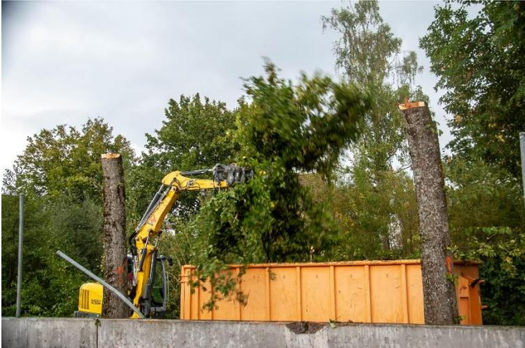
Die Bäume, deren Holz noch nutzbar war, wurden auf einer Höhe von 4 m abgesägt. Die Baumstämme wurden mitsamt der Wurzelstöcke ausgegraben. Diese haben inzwischen eine neue Aufgabe erhalten. Sie wurden an unterschiedlichen Stellen im Ufer eingegraben mit dem Wurzelstock ins Wasser ragend. Diese Wurzelstöcke sehen für den Betrachter sicherlich merkwürdig aus, sie dienen jedoch den Fischen als Fischunterstand, also als geschützter Rückzugsort.
